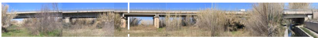
Figura 1. Fotografía del puente actual
